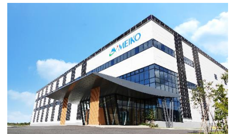
<天童工場：170kWの自家消費型太陽光発電設備>
