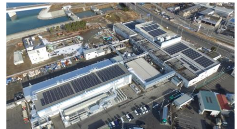
<石巻工場：383kWの自家消費型太陽光発電設備>
