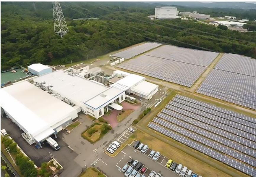
<福島工場：532kWの自家消費型太陽光発電設備とソーラーパーク福島>
