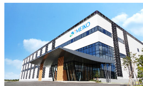
<天童工場：170kWの自家消費型太陽光発電設備>
