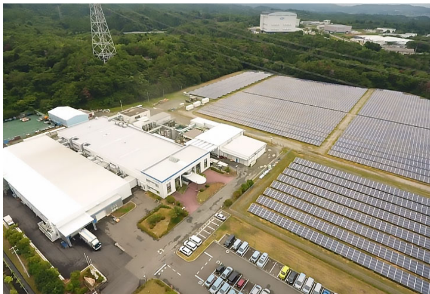
<福島工場：532kWの自家消費型太陽光発電設備とソーラーパーク福島>
