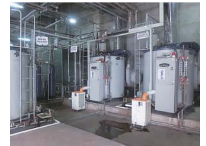
蒸気ボイラー
