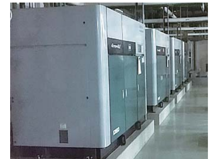
コンプレッサー
