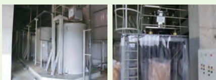
タンク(反応槽プロセス) 遠心分離機
