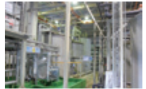
エッチング廃液処理プラント
