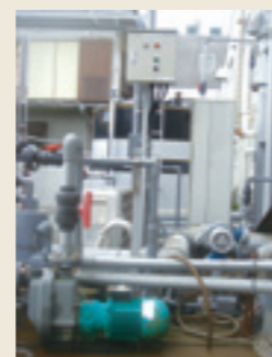
廃酸処理設備
