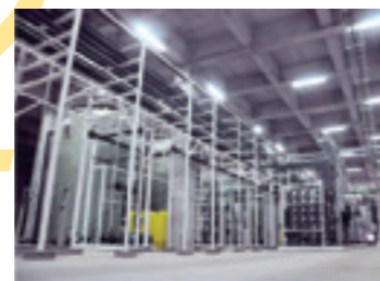
RO水の精製装置
