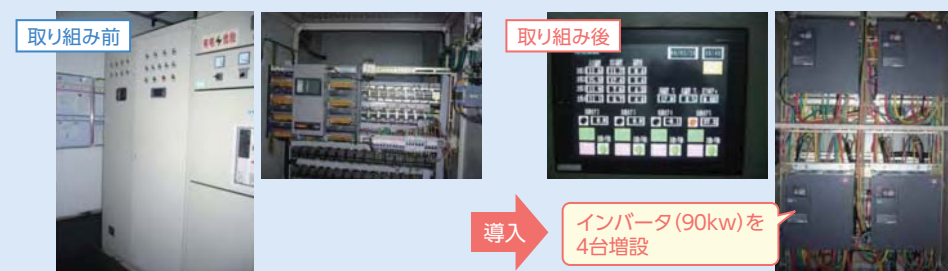
接触器方式による運転方法では、空調負荷に応じて冷凍ポンプの起動および停止をスイッチのON/OFF操作により作業員が手動で行っていたため、運転効率が悪かった。
