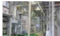
エッチング廃液処理プラント
